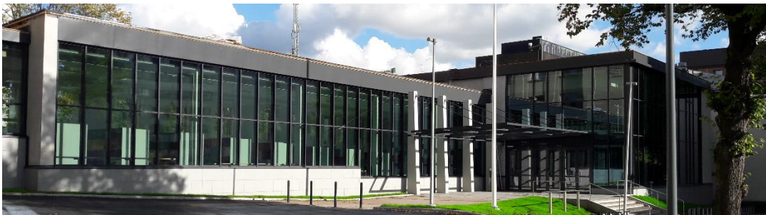
Kuva 2. Vuonna 2016 valmistunut Klassillisen lukion laajennos, jonka on suunnitellut rakennusarkkitehti Hannu Silvennoinen.
